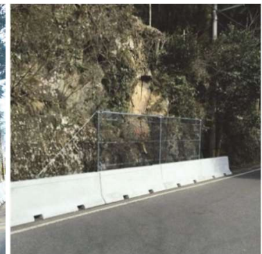
岩盤の剥離場所に設置
