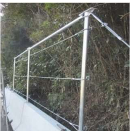
横ロープ設置完了
