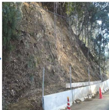
施工後：崩壊土砂を捕捉
