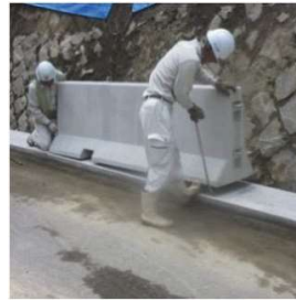
基礎擁壁の設置状況(1)
