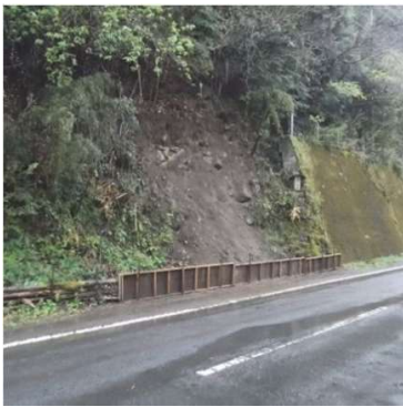
施工前：崩壊現場に仮設の木柵
