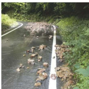
小規模落石の状況
