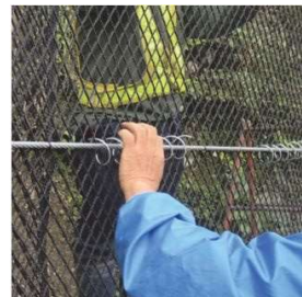
ネットジョイント設置
