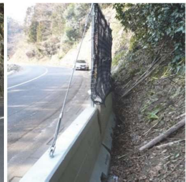
施工後：落石混じり土砂を捕捉
