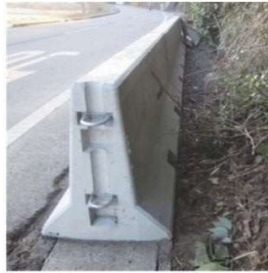
基礎擁壁の側面
