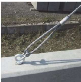
斜ロープと基礎擁壁を接続
