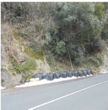
施工前：大型土のう
