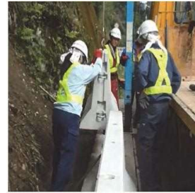
基礎擁壁の設置状況(2)
