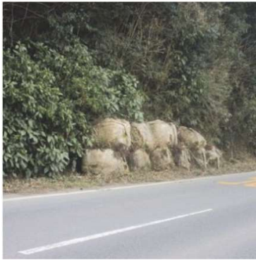
施工前：大型土のう
