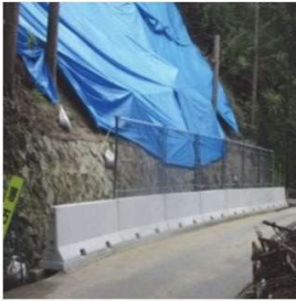
崩壊斜面下に仮設で設置
