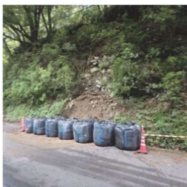
大型土のう対処事例
