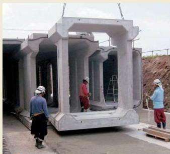
1 ボックス型タイプ ブロックの据付
