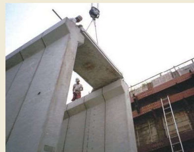
2 スラブの据付
