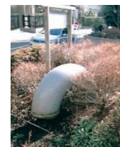
●地上部 換気孔
