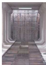
●現場打ち端壁
