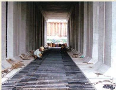
4 底板現場打ち部の配筋
