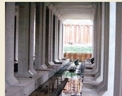
3 プレキャストブロックの据付完了
