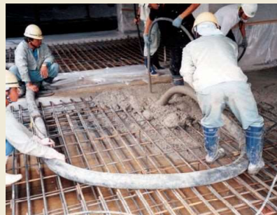
5 底板部コンクリート打設
