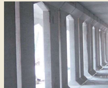
7 完成した遊水池の内部
