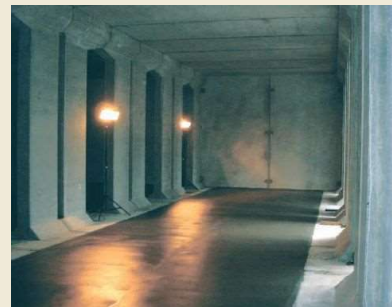
6 コンクリート打設完了
