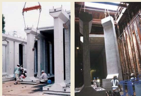
スタンド型タイプ ブロックの据付
